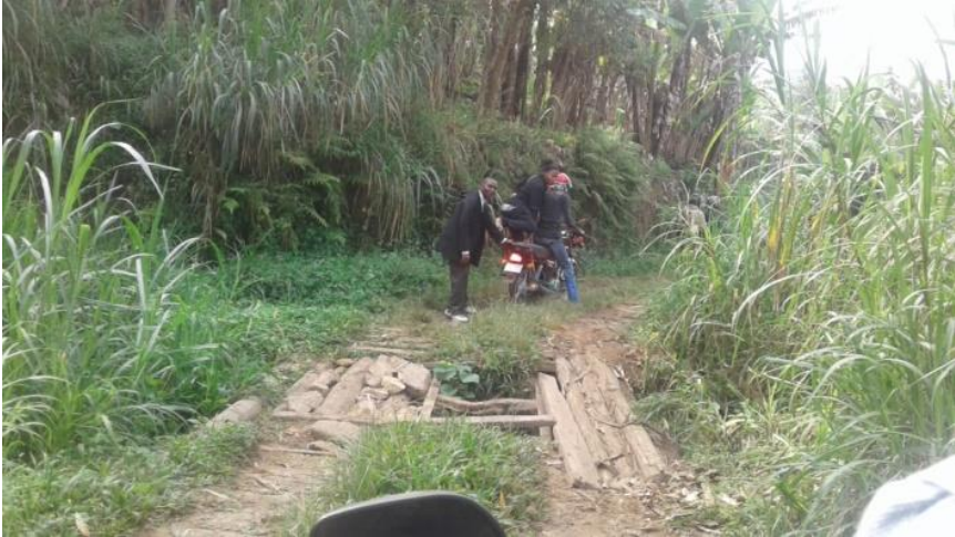
Pont de la route menant vers Buabo/Masisi, ©Ulimwengu
